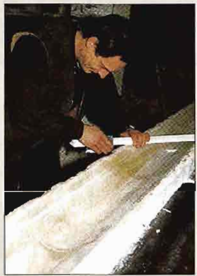
Der Stukkateurmeister bei der Feinarbeit am Zugflügel.
